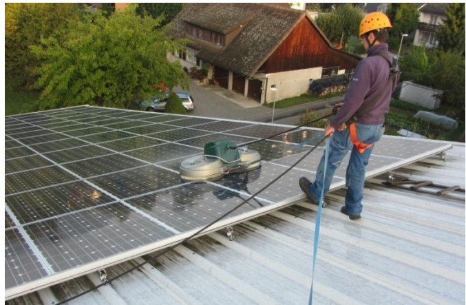
Professionelle Modulreinigung (Foto: BE Netz AG)
